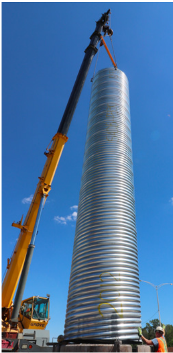
Caissons pour le REM, Montréal, QC
