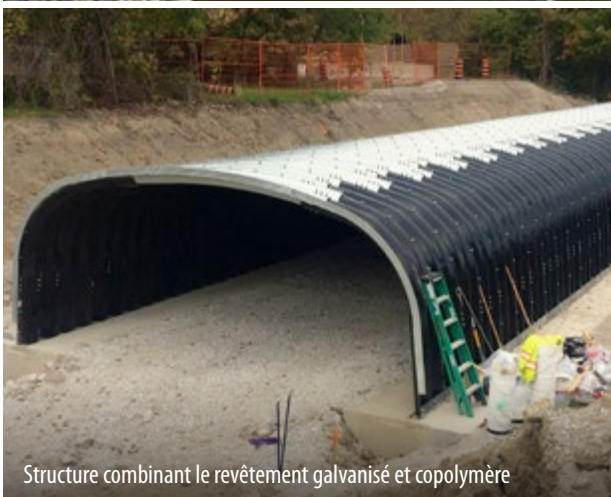
Construction en deux étapes, pont d'étagement autoroutier, Windsor, NÉ
