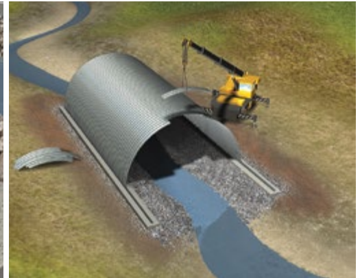
Les tôles sont fixées une à une pour former les autres sections de l'arche.
