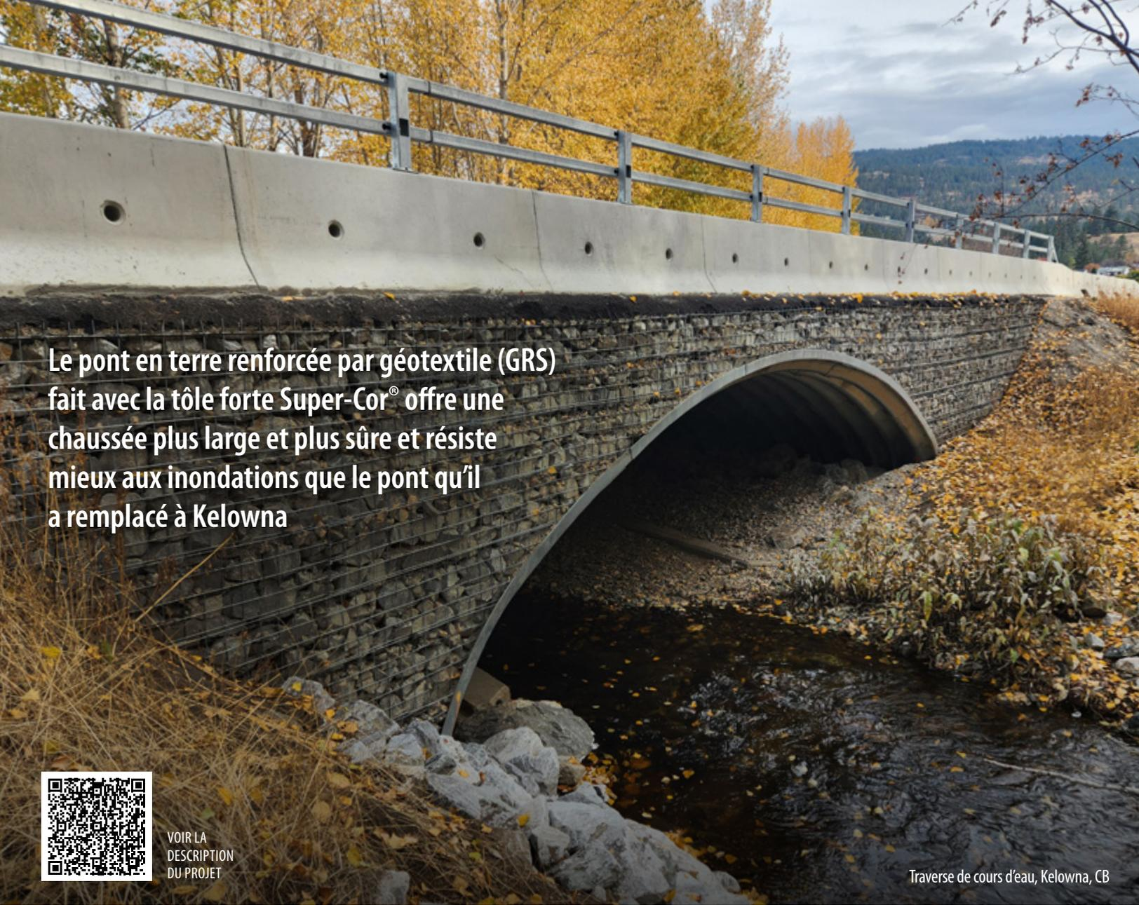
**Le pont en terre renforcée par géotextile (GRS) fait avec la tôle forte Super-Cor® offre une chaussée plus large et plus sûre et résiste mieux aux inondations que le pont qu'il a remplacé à Kelowna**
