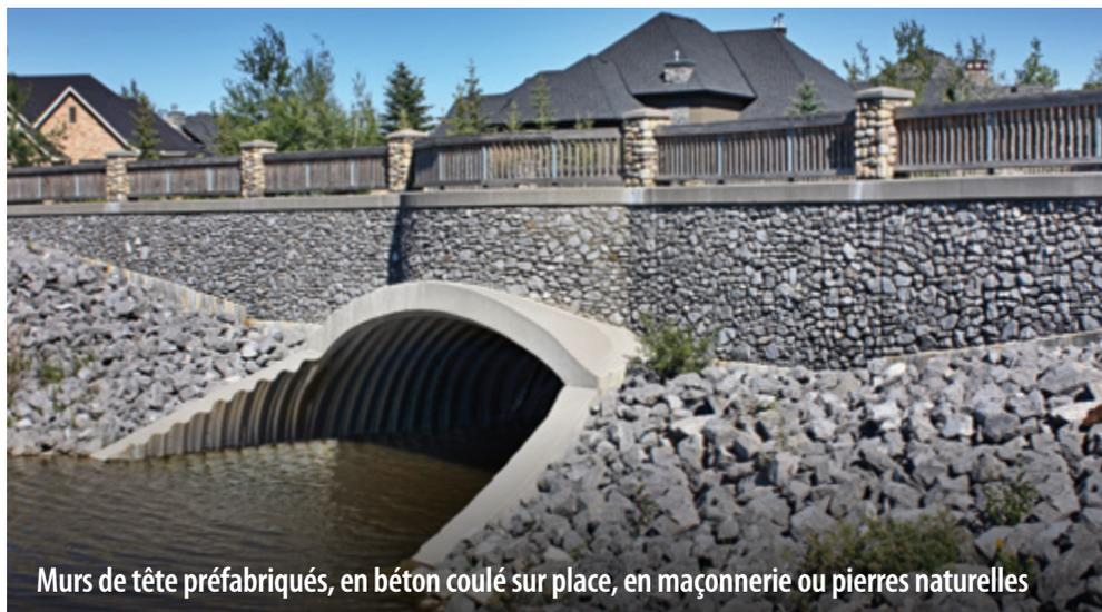
Murs de tête préfabriqués, en béton coulé sur place, en maçonnerie ou pierres naturelles
