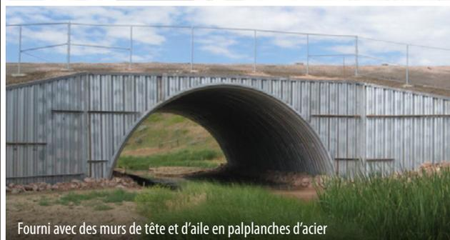
Fourni avec des murs de tête et d'aile en palplanches d'acier
