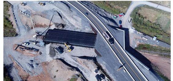
Deuxième phase : l'assemblage des tôles fortes est presque terminé, et le remblayage est en cours.
