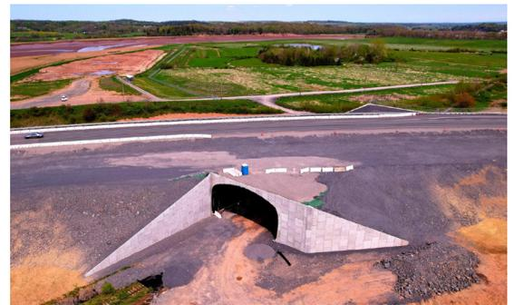
Deuxième phase : la structure est achevée; il ne reste que le nivellement final et le pavage à faire.
