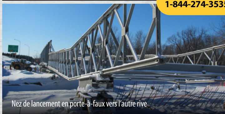
Mise en place à partir d'un côté sans matériel de levage
