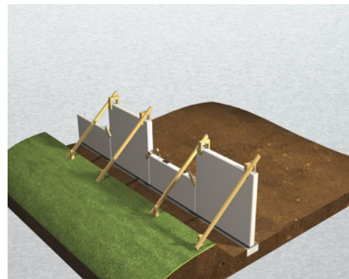
Les panneaux préfabriqués, les renforts et les pinces sont mis en place.
