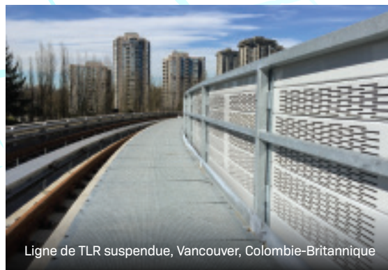
Ligne de TLR suspendue, Vancouver, Colombie-Britannique
