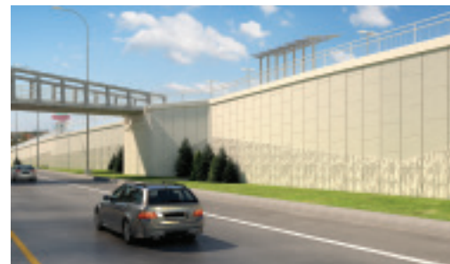
Murs de soutènement et culées
