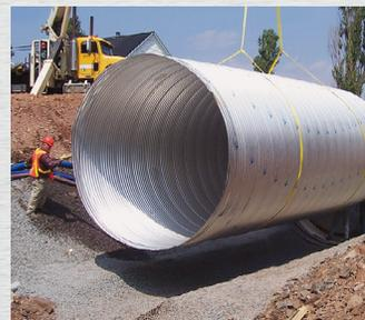
Dans les milieux corrosifs, le revêtement aluminisé de type 2 offre une excellente résistance à l'abrasion, les caractéristiques de surface de l'aluminium, la robustesse de celui-ci et l'économie de l'acier en font un matériel de
