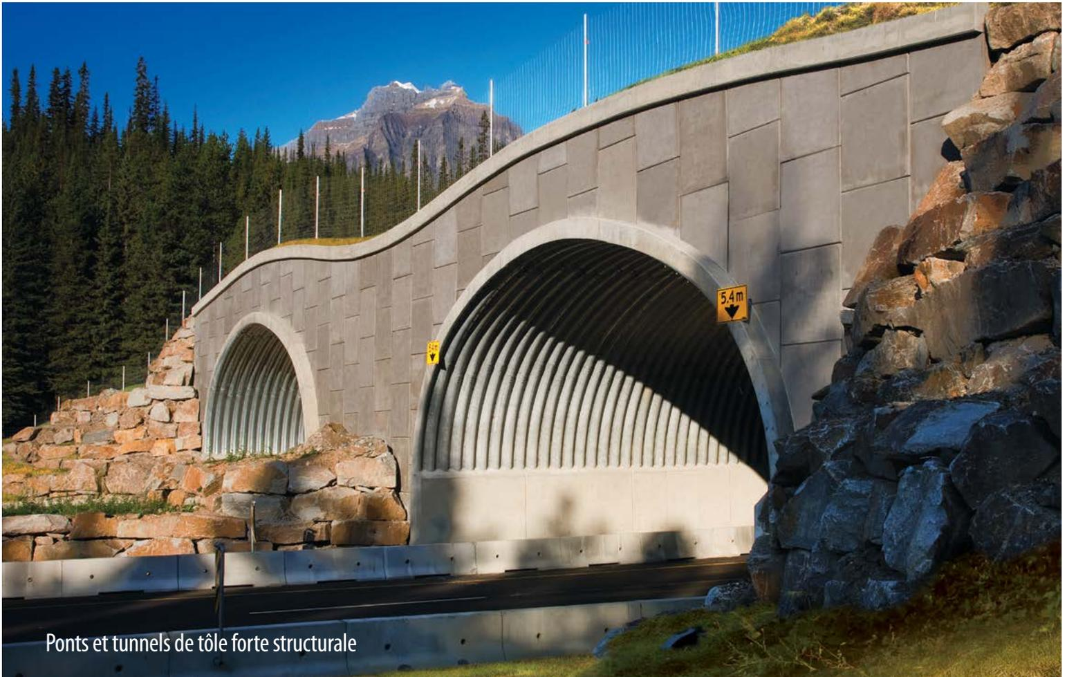
Ponts et tunnels de tôle forte structurale
