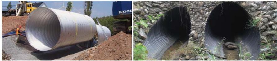
Le tuyau de tôle ondulée d'AIL (TTO) est un matériau de choix, parce qu'il offre une combinaison optimale de robustesse, de flexibilité et de rendement.
