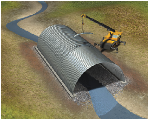
S'ils sont requis, des nervures de renfort sont ajoutées.
