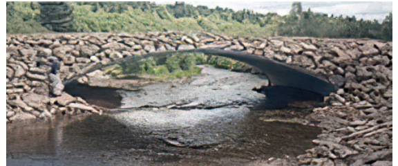
Super•Cor BoxCulvert soutient la route forestière.
